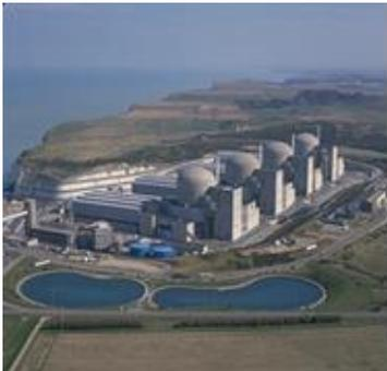
Les opérations vont se prolonger jusqu'en mai 2016. Les équipements les plus importants sont l'objet d'un programme de maintenance approfondie, le système de commande du réacteur sera profondément modifié... au prétexte d'améliorer la robustesse du réacteur. Ni la cuve, qui reçoit le combustible radioactif, ni l'enceinte de confinement, ultimes barrières de protection ne pourront être changées...
